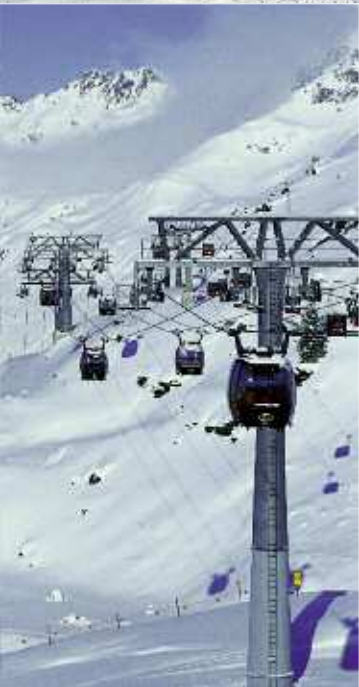
Les 20 millions d'euros annuels uniquement consacrés au domaine skiable justifient la modernité des installations.
